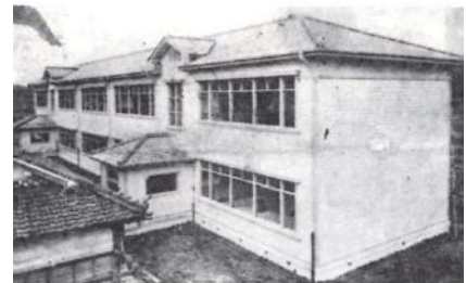
建設中の新校舎
